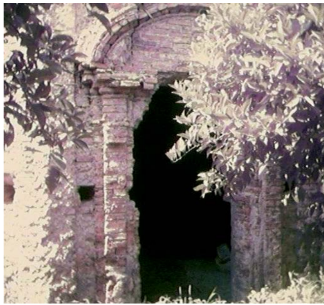
La Chiesa della Trinità, conosciuta anche come «Mattunusa», completamente accerchiata dalla vegetazione
